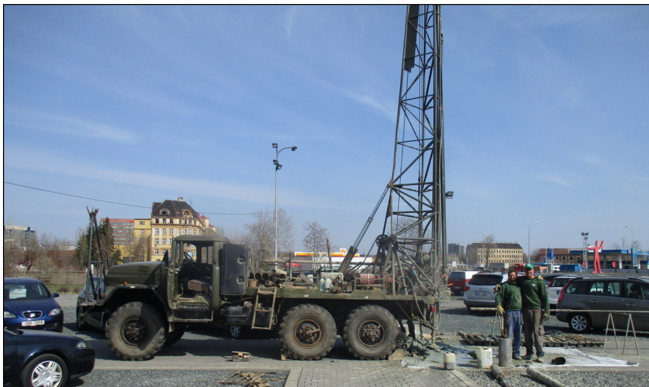
Obr.2: Hloubení průzkumného vrtu V3 pomocí těžké vrtné soupravy URB 2,5
